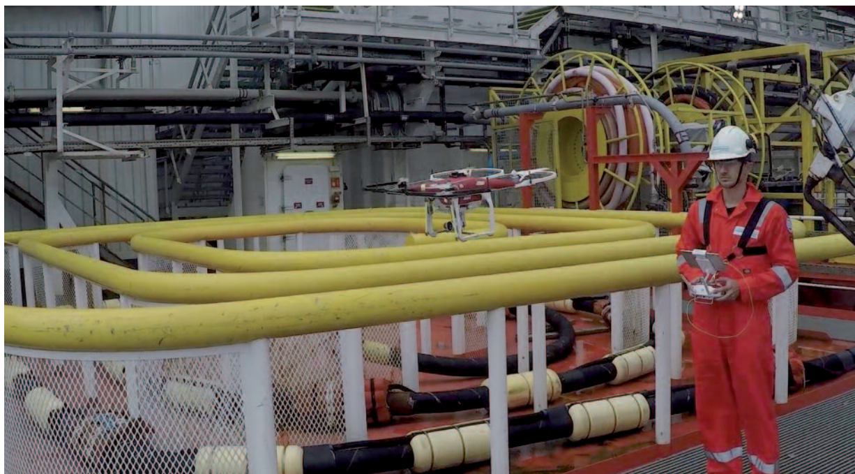
Un piloto de dron iniciando la inspección de una plataforma. / Foto: DNV GL
