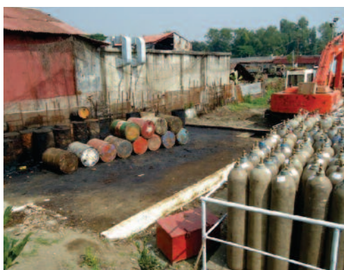
Fig. 3: Mejoras en las instalaciones de PHP Family (Bhatyari - Chittagong). De arriba a abajo: impermeabilización del suelo; zona de almacenamiento de residuos peligrosos; y tratamiento y almacenamiento de combustibles y bombonas.
