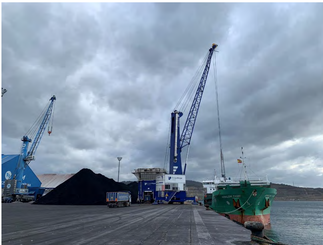
Foto 3. Descarga de coque. Muelle A1. Puerto exterior de A Coruña.
